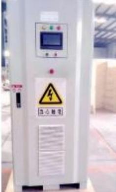
МТР - 1000 - 0100Т - это продукт с номинальной выходной мощностью 100 кВт в семействе блоков питания серии МТР. Он использует промышленный шкаф 800 \* 1800 \* 800 и сенсорный ЖК-экран для программируемого управления и мониторинга.
